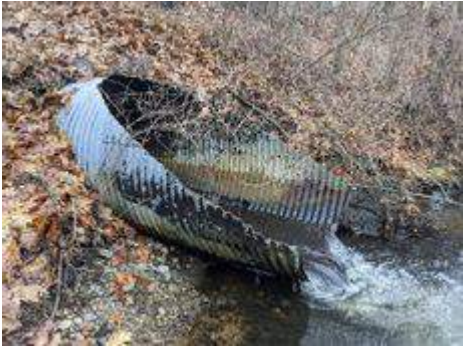
cul23 Outlet Pipe
